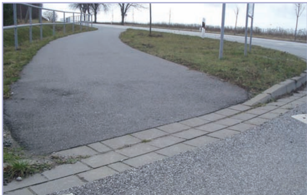
Abb. 6: Bordsteinabsenkung mit Rinnsteinen (Neukloster, LK Nordwestmecklenburg)
